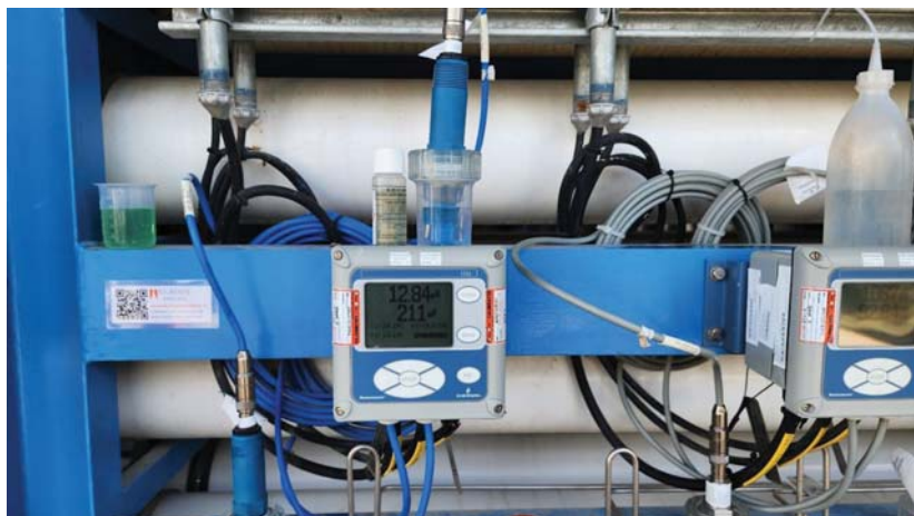
ภาพ แสดงการจุ่มน้ำยามมาตรฐานสำหรับการสอบเทียบ ค่าที่วัดได้ต้องใกล้เคียงกับน้ำยามมาตรฐาน ถ้าค่าต่างกันมากเป็นไปได้ว่า ตัวเซนเซอร์วิเคราะห์ ORP เสีย
