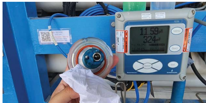
ภาพ การเช็ดทำความสะอาดหัวโพรบ โดยการใช้ผ้าสะอาด และทิชชูซับบริเวณหัววัด
