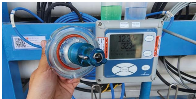
ภาพ การถอดหัวโพรบออกมาเพื่อตรวจสอบ ก่อนทำความสะอาด
